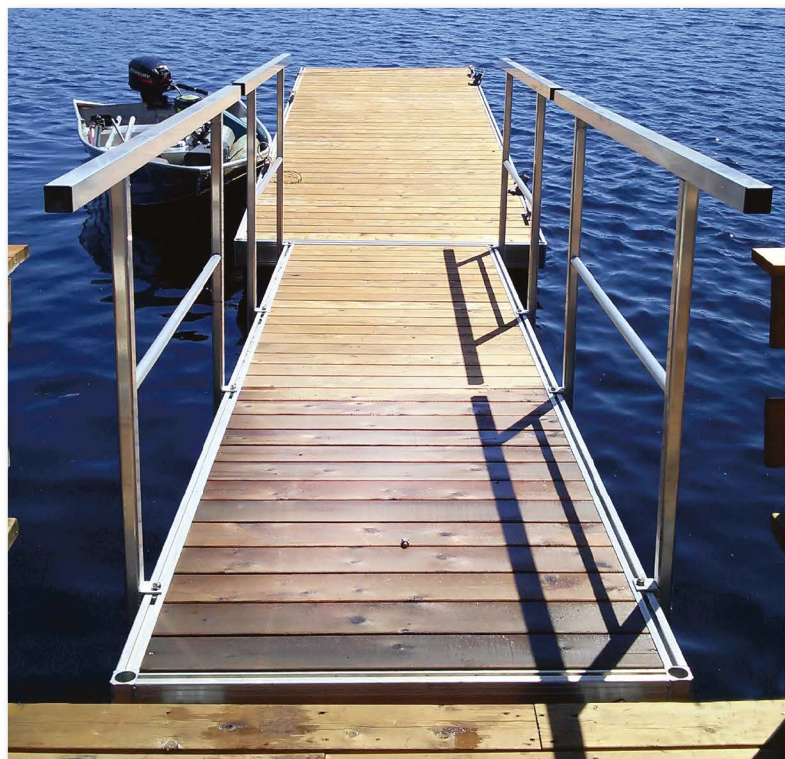
Quatre mains courantes sur passerelle de 16pi.
